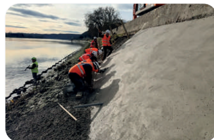
Réparation en cours par l'équipe du SMGSN
