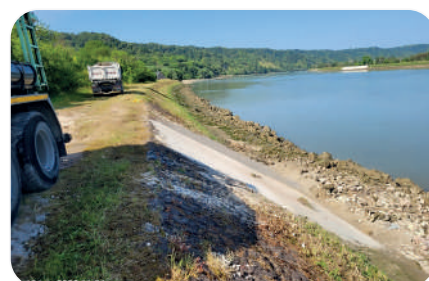
Fin de chantier à Yville-sur-Seine
