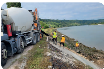
Réparation d'un désordre à Yville-sur-Seine
