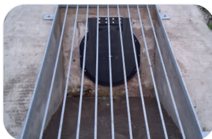
Chantier de remplacement de clapet à Heurteauville
