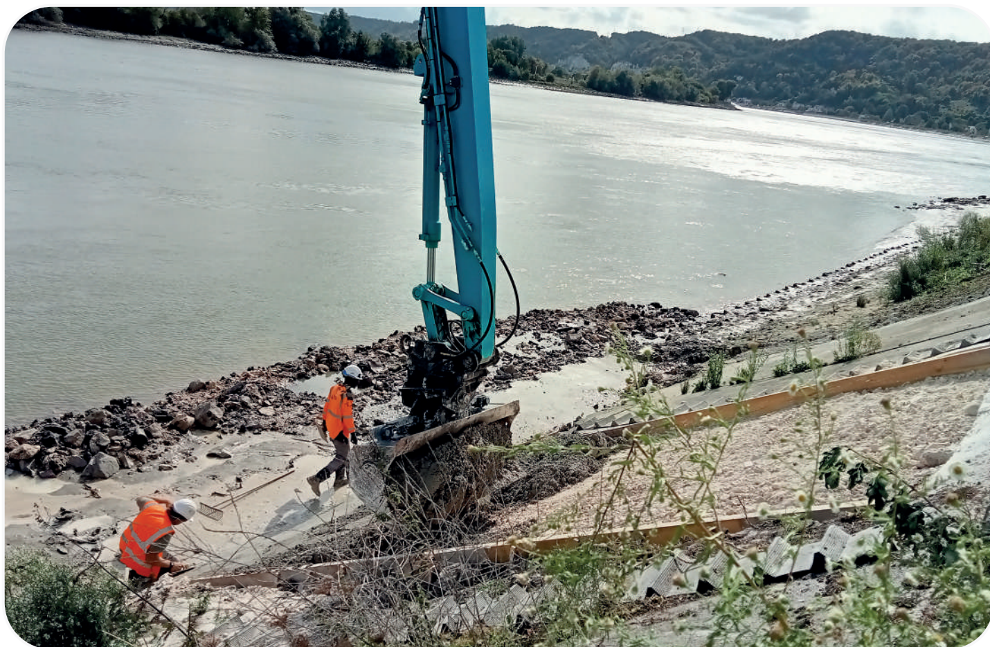
Réfection de perré à Heurteauville
