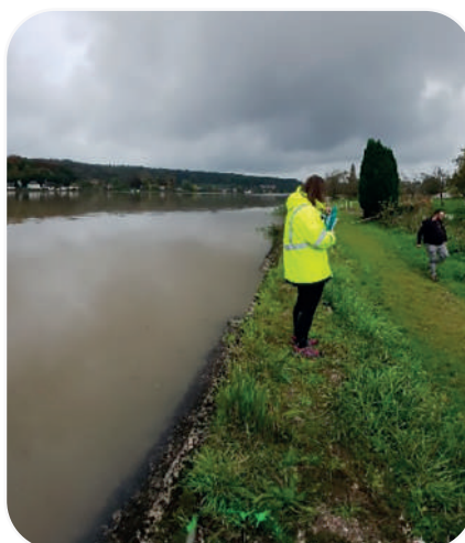
Inspection de la digue pendant une crue
