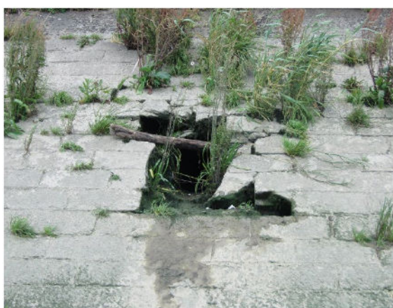
Photos de dégradations sur l'ouvrage : érosion autour d'un réseau (photo 1) et déformation en toit (photo 2) ©Dpt76
