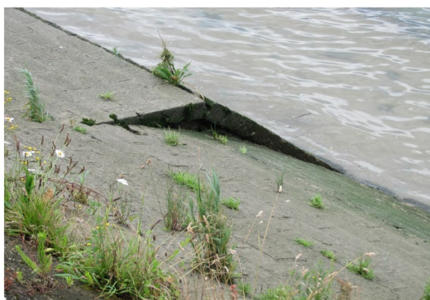
Photos de dégradations sur l'ouvrage : érosion autour d'un réseau (photo 1) et déformation en toit (photo 2) ©Dpt76
