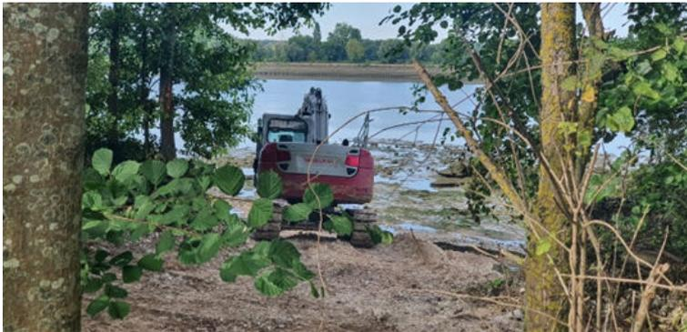
Réalisation d'une rampe en marne pour permettre l'apport des enrochements. Utilisation d'une pelle à chenilles car présence de poches de vase avec risque d'enlèvement
