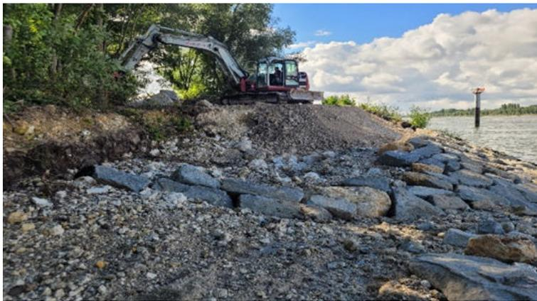
Mise en place des enrochements selon un plan précis pour restaurer l'ouvrage conformément à sa hauteur initiale.
