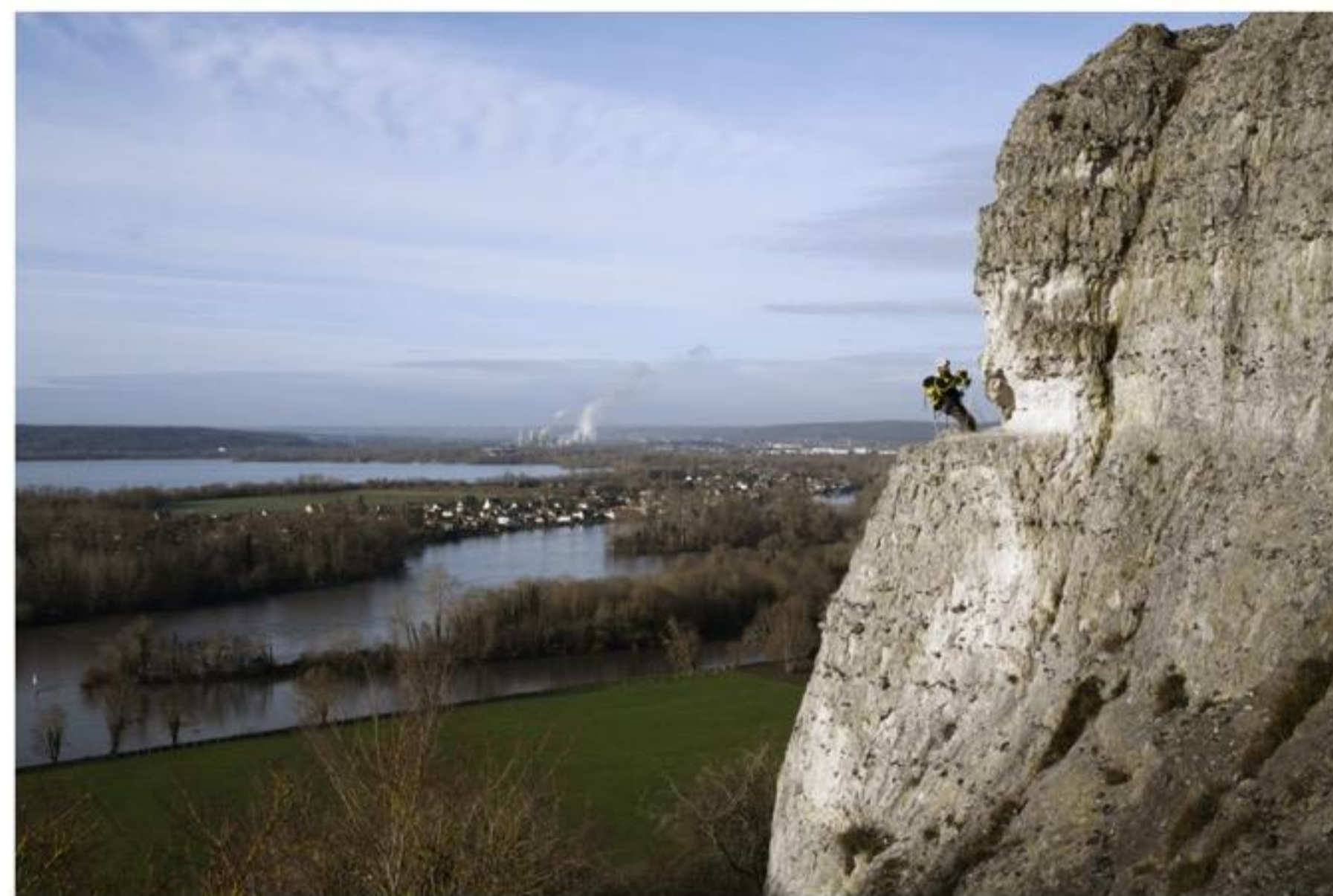
Relevé de jauges de fissure sur la Roche Bardin, Amfreville-sous-les-Monts Claire Tenu, janvier 2021
